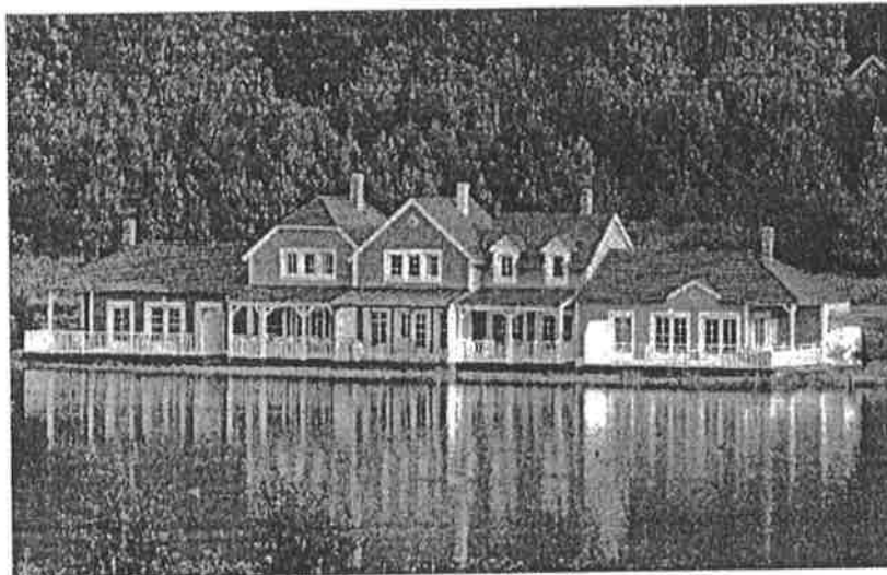
Le coût moyen des travaux pour un cottage de 75 m 2 est d'environ 15 000 euros hors taxes. Jean-Marie Champagne
