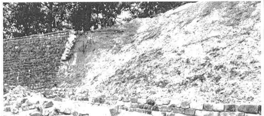
La restauration de la contrescarpe est bien avancée. D'autres projets suivront.
