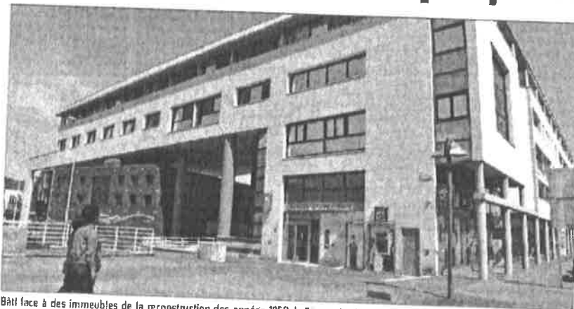
Bâti face à des immeubles de la reconstruction des années 1950, le Forum des Trois gares avait surpris par sa modernité.
