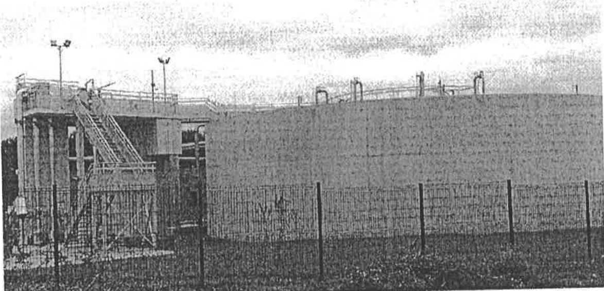
La station de Bohain est inaugurée demain jeudi 22 septembre. Les riverains ne seront plus incommodés par les mauvaises odeurs.
