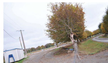
A l'entrée de l'exploitation agricole, la dalle du bâtiment de 400m 2 est coulée. Tout devrait être terminé pour un début d'activité au printemps.
