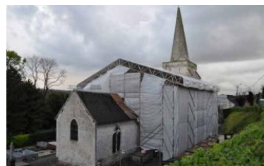
L'église sera en travaux pour un an minimum.
