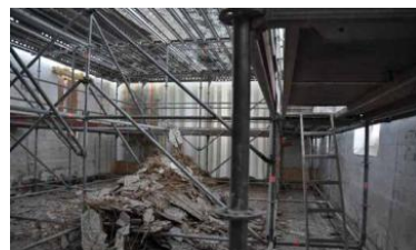
Sur le sol de l'église, le plâtre des voûtes qui a été retiré.
