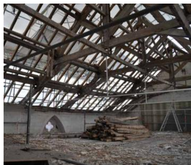
La charpente vue d'en dessous.
