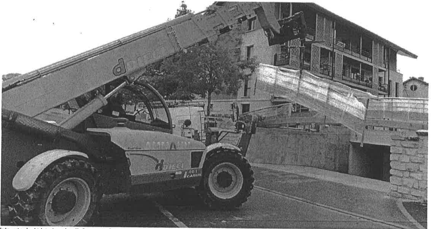
Logivam est sur le point de terminer un immeuble d'appartements, d'autres sont en cours de construction. Jean-Marie Clémence
